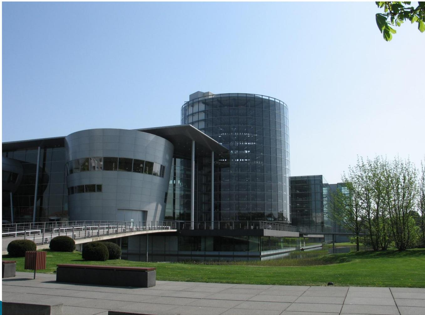
大众汽车公司将一个完整的环境方案纳入整体规划，包括灯光照明布置、气候和通风系统、保护敏感的动植物以及保持城市生活质量等多个方面。所以，在大楼建造的时候就注重结构深度尽量浅，以确保足够的渗水面积，保持地下水的平衡。面积50000平方米的室外区域，设计为绿化面积和水面。大楼四周，使用扩音器播放多种鸟类鸣叫的声音，使鸟儿远离玻璃幕墙，室外区域内安装了特制的钠气灯，黄色系的灯光不会惊扰邻近植物园内的昆虫。
